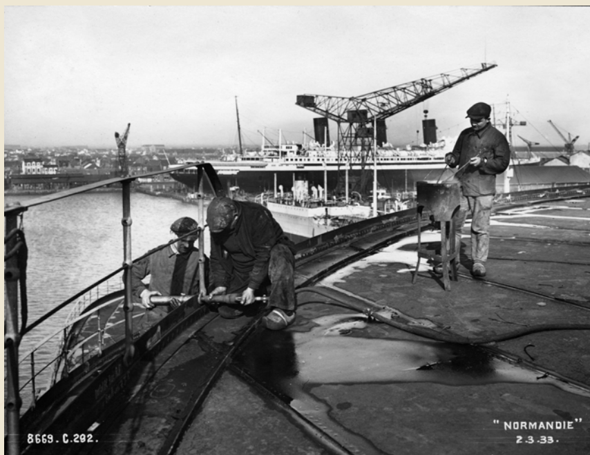
Chaussés de leurs sabots de bois, trois riveteurs installent les éléments d'acier qui constituent le bastingage. Photographe : inconnu. Collection Saint-Nazaire Agglomération Tourisme – Écomusée. Fonds Chantiers de l'Atlantique. Saint-Nazaire, le 2 mars 1933.
