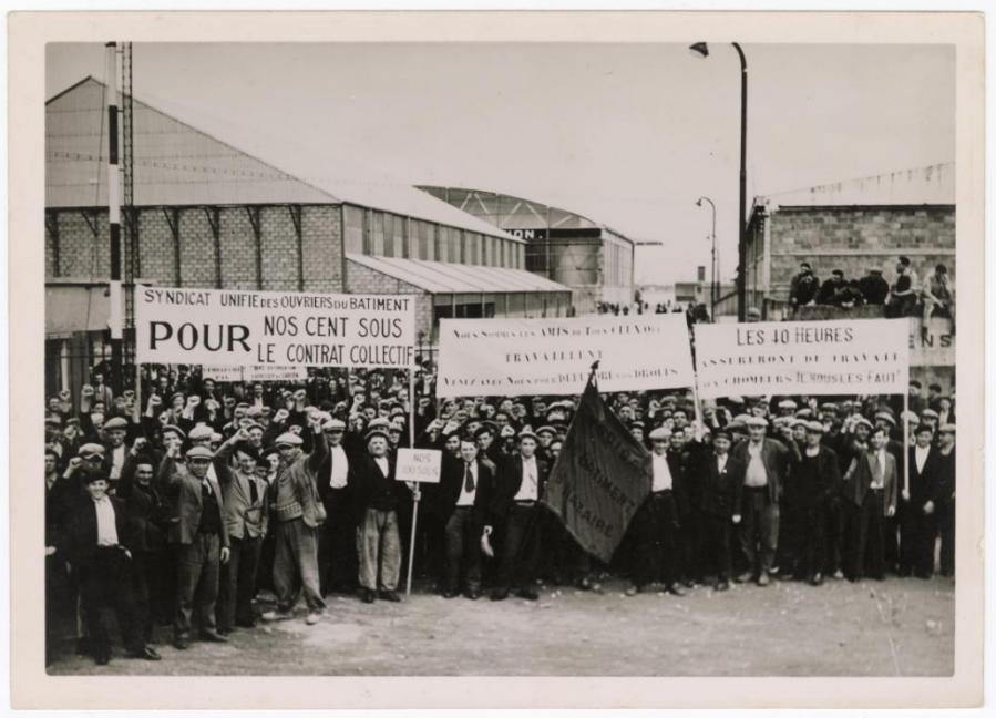
Manifestation des ouvriers du bâtiment aux chantiers lors des grèves de 1936. Photographe : inconnu. Collection Saint-Nazaire Agglomération Tourisme – Écomusée.
