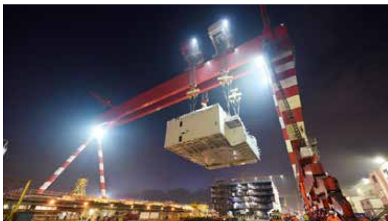
Sous-station électrique en cours d'assemblage aux Chantiers de l'Atlantique à Saint-Nazaire. (c) Chantiers de l'Atlantique - Bertrand Bigier
