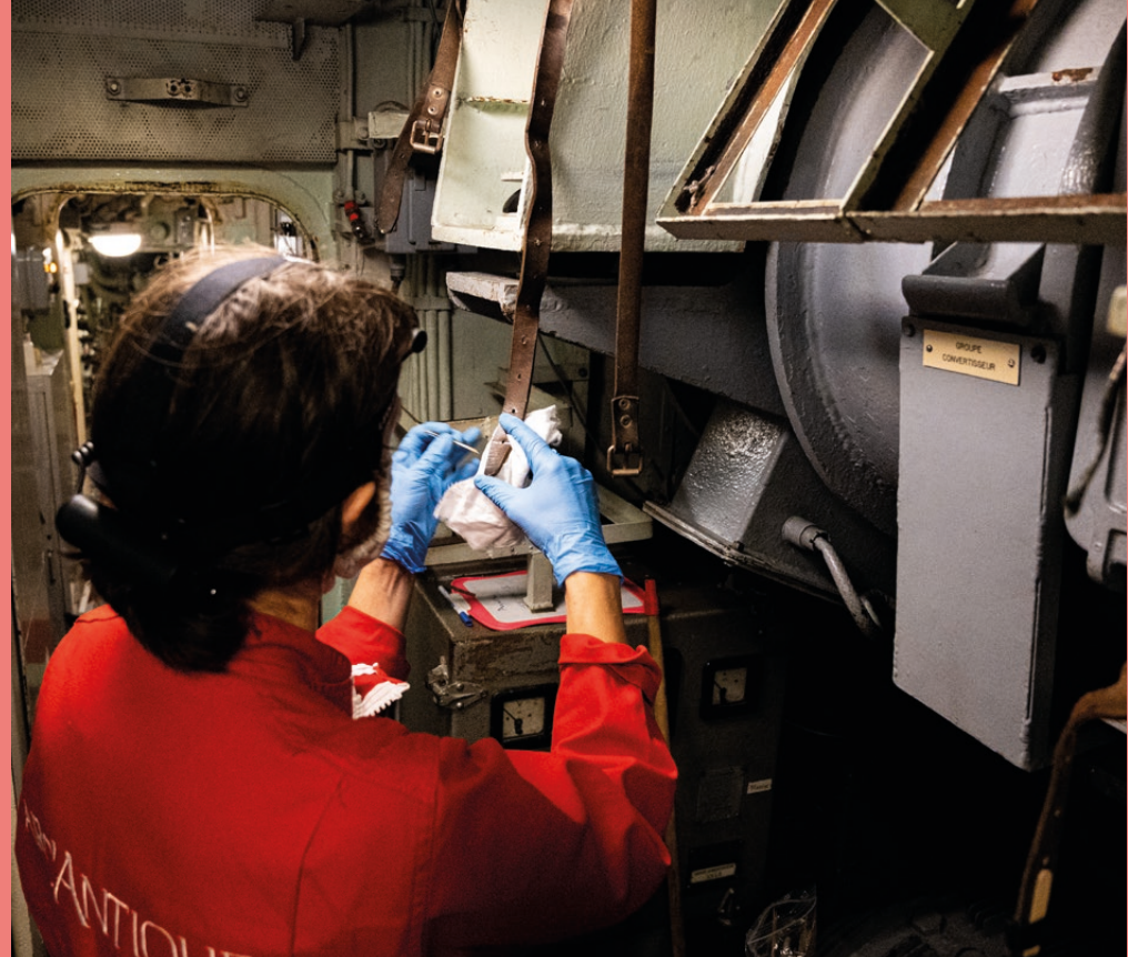
Vue intérieure du sous-marin Espadon en cours de restauration - Photographe M. Leduc
