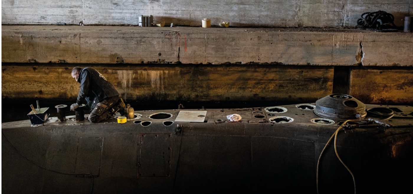
Application d'un traitement anticorrosion sur la coque du sous-marin - Photographe : M. Leduc
